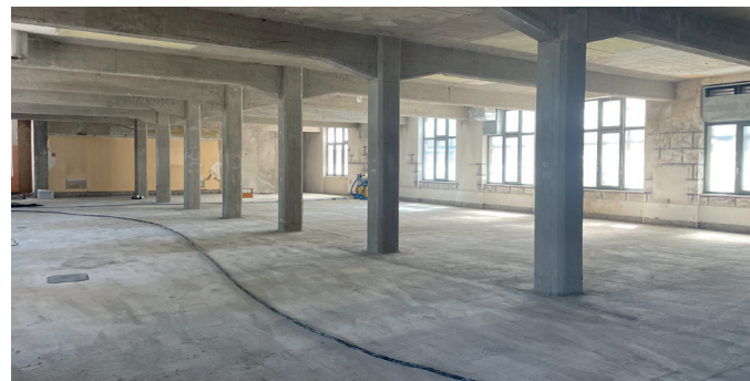
Ein Blick auf die aktuellen Umbauarbeiten im denkmalgeschützten Gebäude im alten Steintal-Bowling Haus.
