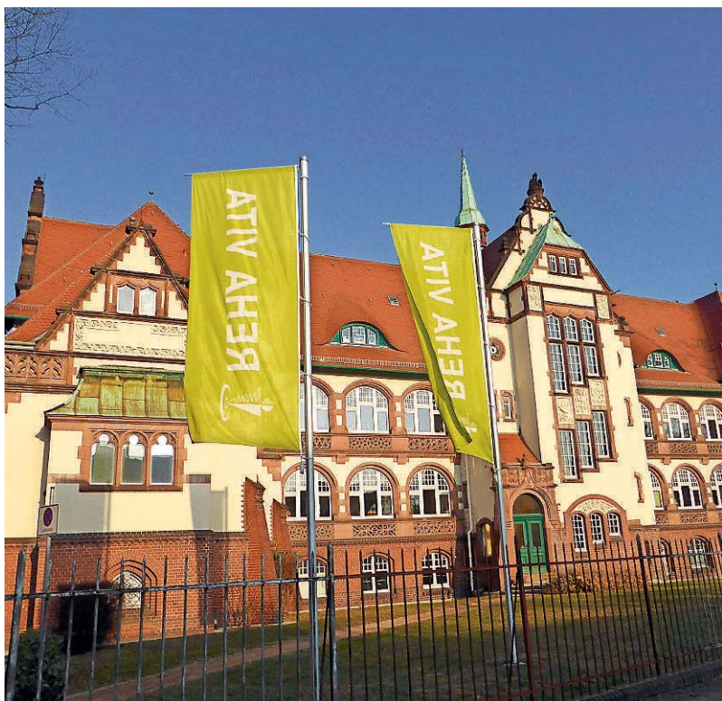
Die Räume in der Feigenstraße werden langsam zu klein. Ein Neubau soll Entlastung und Platz für ein Kindertherapiezentrum schaffen.
