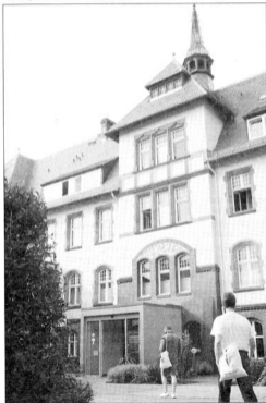
Das Stiftshaus der Auguste-Stiftung zu Cottbus hat sich seit fünf Jahren erfolgreich zum Gesundheitszentrum der Reha Vita entwickelt. Noch in diesem Jahr wird eine Erweiterung erfolgen, um die Abläufe weiter zu verbessern
